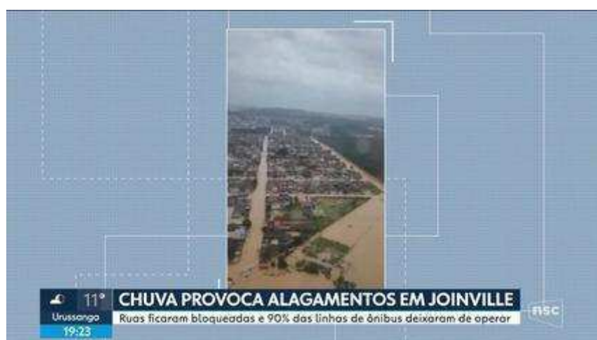
Chuva provoca alagamentos em Joinville
