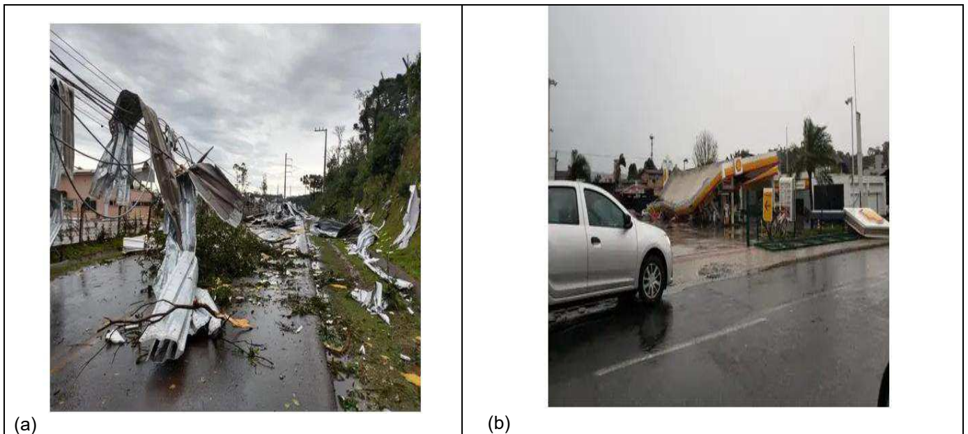
Figura 6 – (a) Imagem de destroços atingindo a rede de transmissão em uma estrada de Chapecó; (b) Cobertura de um posto de combustível em Blumenau, derrubada com o vento forte que passou por SC no dia 30/06/2020. (Fonte: NSC).
