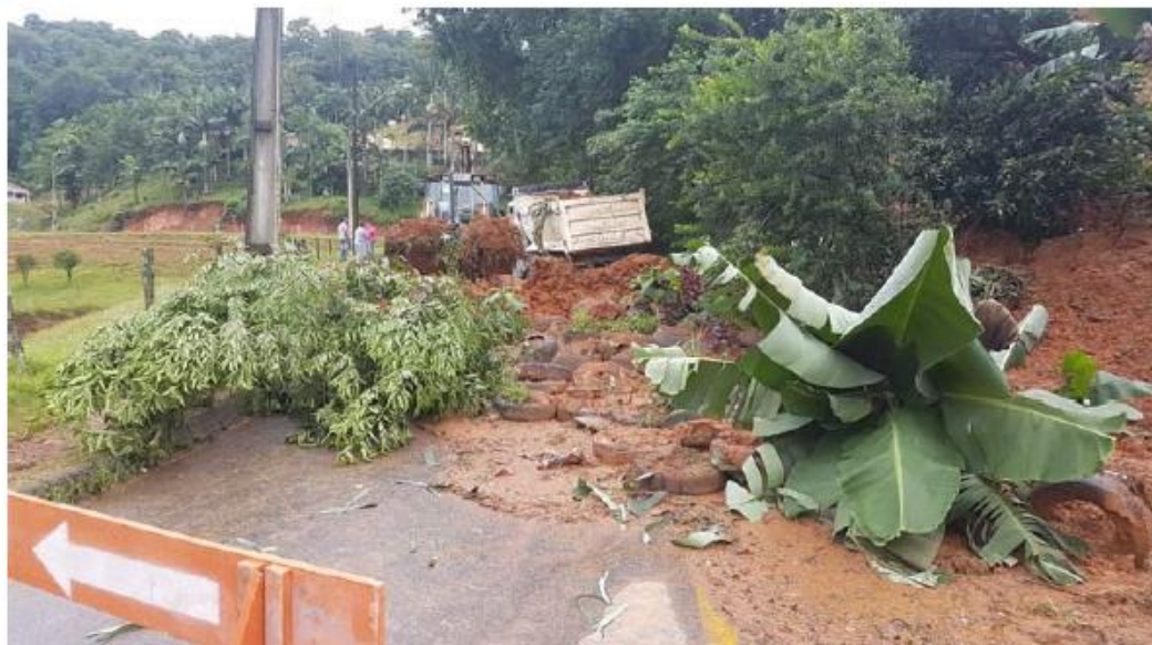
Rua Cristiano Karsten, bairro Testa Salto, desobstruída neste domingo (1/04) | Foto: Defesa Civil de Blumenau
