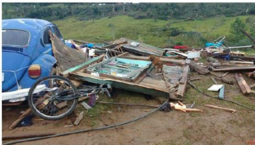
Casa destruída em Ponte Alta, no norte do estado. Foto: Defesa Civil
