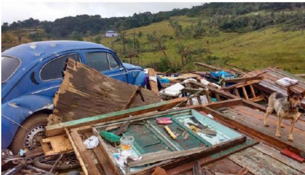
Casas foram destruídas em Ponte Alta do Norte Foto: Defesa Civil / Divulgação
